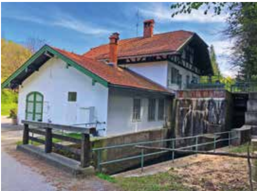
Hist. Elektrizitätswerk (um 1900) (CL)
