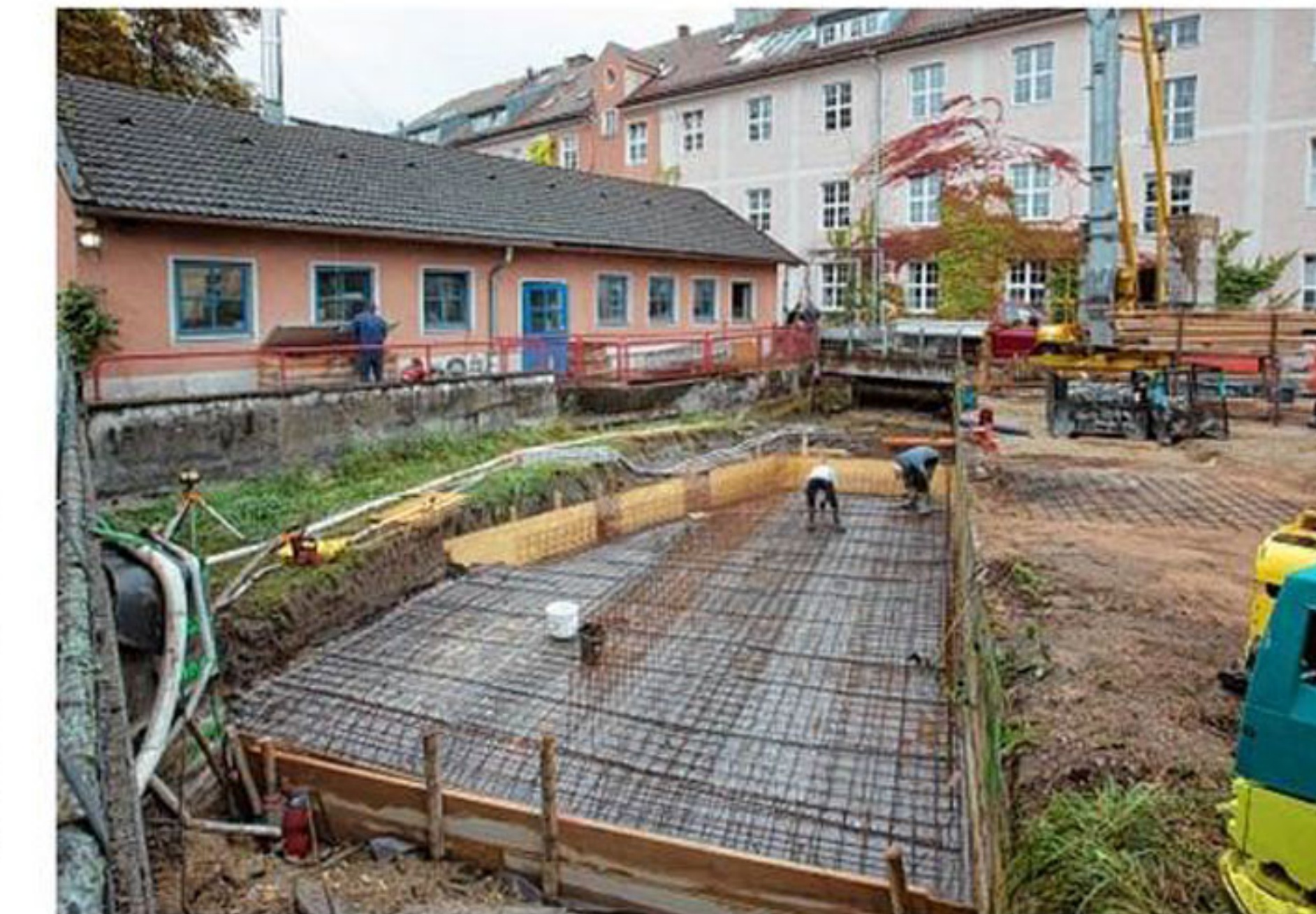
Ein E-Werk entsteht an der Freien Waldorfschule Chiemgau.
