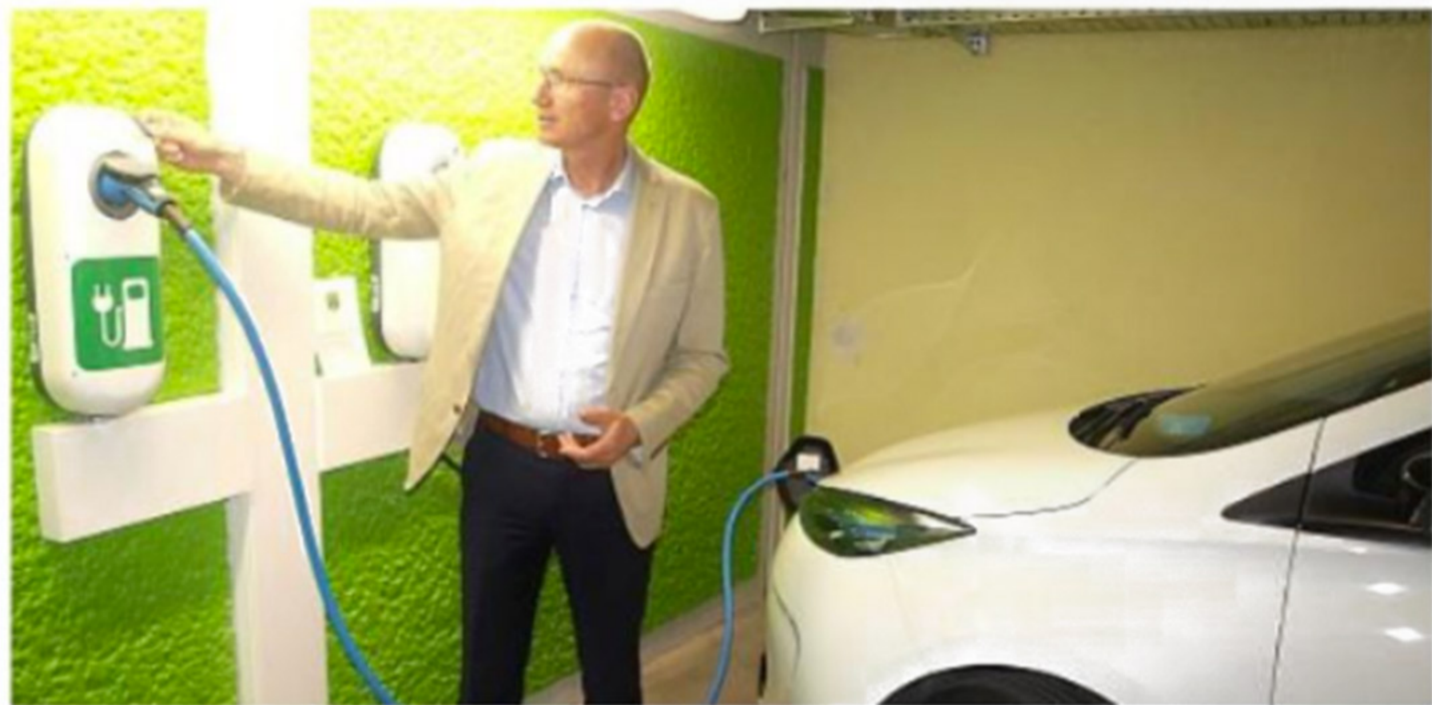
Neue E-Ladestation im Parktunnel am Traunsteiner Bahnhof: Oberbürgermeister Christian Kegel nahm die neue Anlage in Betrieb.
