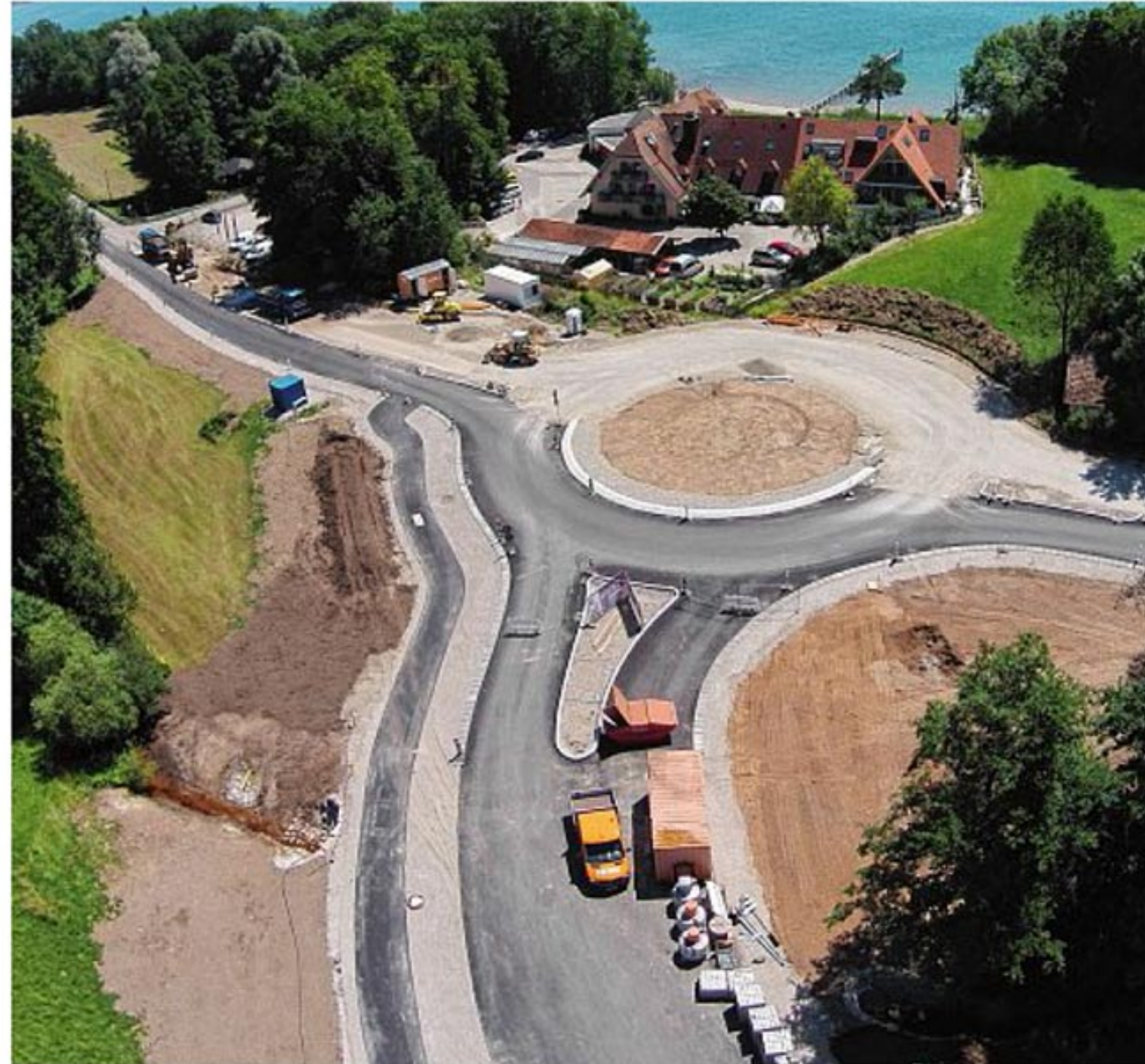
Das mit einer Drohne aufgenommene Luftbild zeigt die Baustelle der Kreisverkehrsanlage beim Hotel-Restaurant Malerwinkel in der Gemeinde Seeon-Seebruck. Mitte August soll die neue Verkehrsanlage mit Radweganschluss an den Chiemsee-Uferweg fertig sein.
