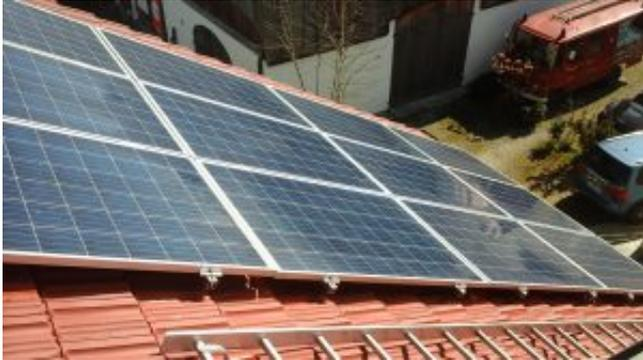
Die polykristallinen PV-Module befinden sich auf der Südseite neben einer Gaube und auf der Westseite des Daches mit einer Neigung von 26 Grad.
