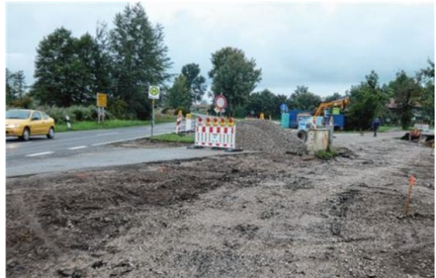
Die Bauarbeiten für den Buswendeplatz an der Staatsstraße bei Hirschau laufen bereits. Es handelt sich um eine der letzten Chiemseerundweg-Maßnahmen in der Gemeinde Grabenstätt.ü FOTO MM
