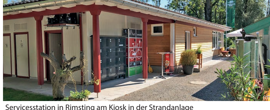
Servicesstation in Rimsting am Kiosk in der Strandanlage
