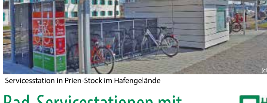
Servicesstation in Prien-Stock im Hafengelände
