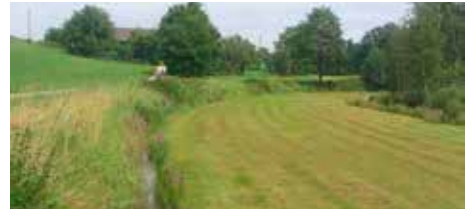
Im komplexen Wasserversorgungssystem zwischen Hofstättler und Rinser See führt dieser Graben bei hohen Wasserständen dem tiefer liegenden Rinser See Wasser aus dem Hofstättler See zu. (AG)
