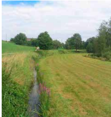
Im komplexen Wasserversorgungssystem zwischen Hofstätter und Rinser See führt dieser Graben bei hohen Wasserständen dem tiefer liegenden Rinser See Wasser aus dem Hofstätter See zu. (AG)
