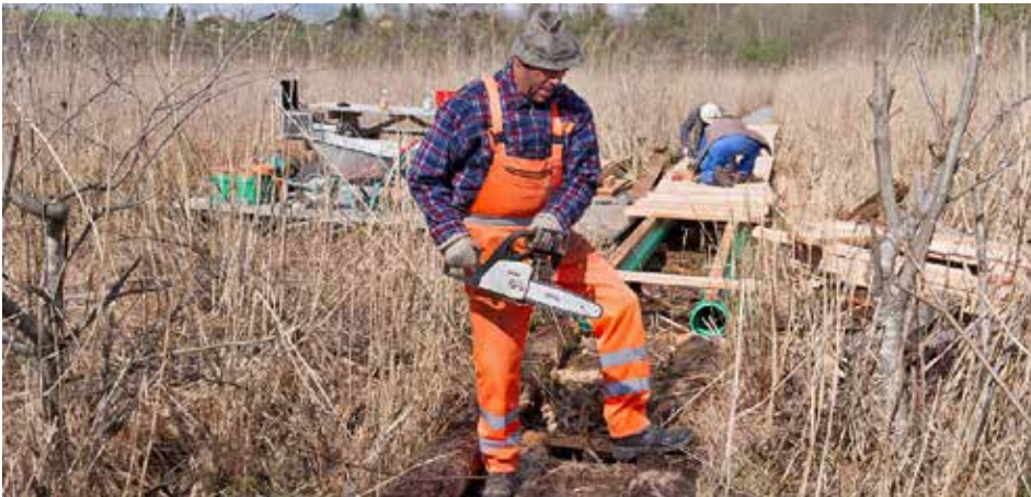
Freiwillige Helfer renovierten den Steg von Grund auf und ersetzen die verfallenden Holzstämmе durch (grüne) dauerhafte Plastikrohre. (GJ)
