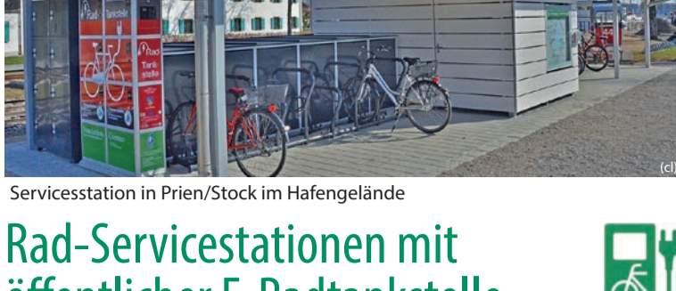
Servicesstation in Prien/Stock im Hafengelände
