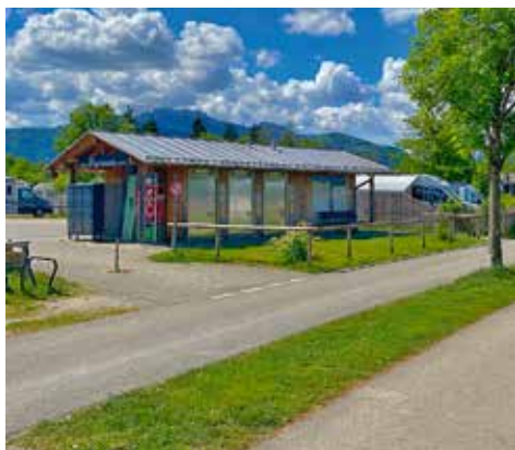
Servicestation in Bernau-Felden im Chiemseepark (CL)
