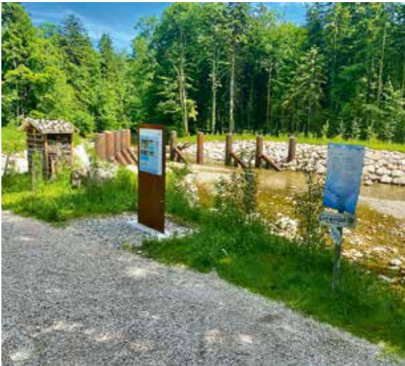
„Wildholzrechen“ am Siggenhamer Wehr (CL)
