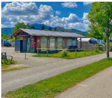
Servicestation in Bernau-Felden im Chiemseepark (CL)
