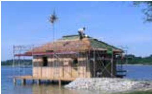
Hütte an der Prienmündung
