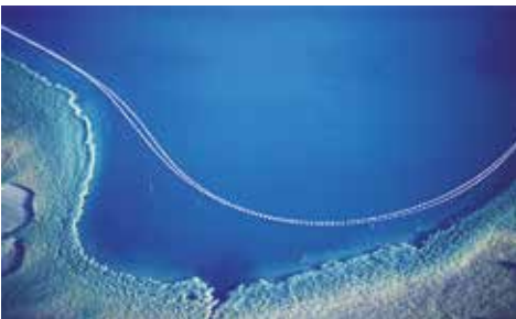
Ringkanal - vor der Rohrabsenkung (T-PM_2)
