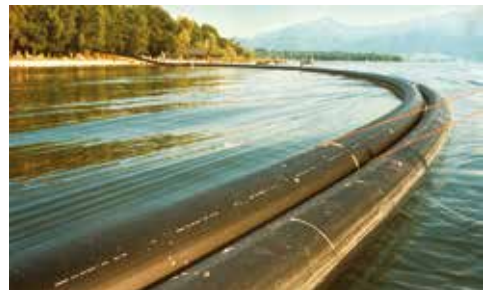
Ringkanal - vor der Rohrabsenkung (T-PM_2)
