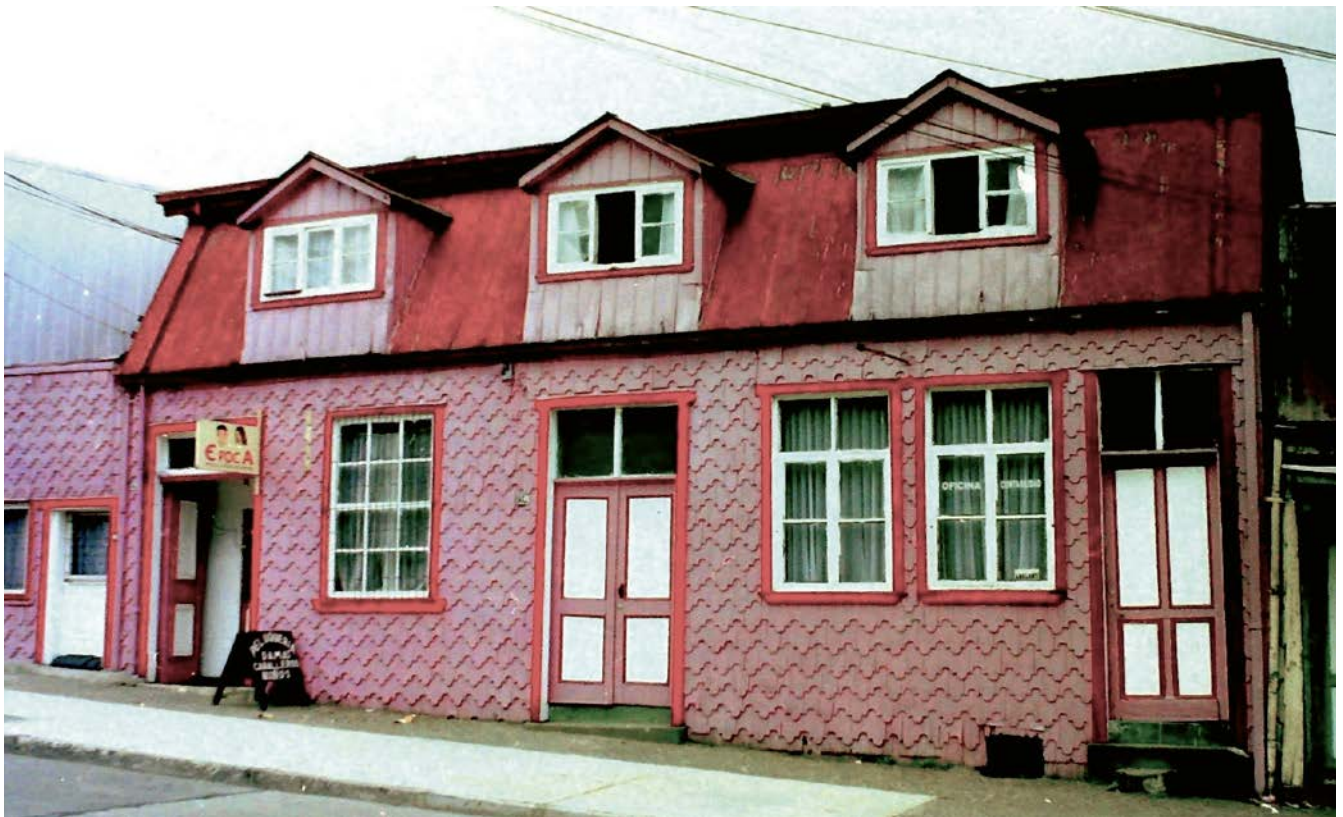
Chile – Holzschindelverkleidetes Haus
