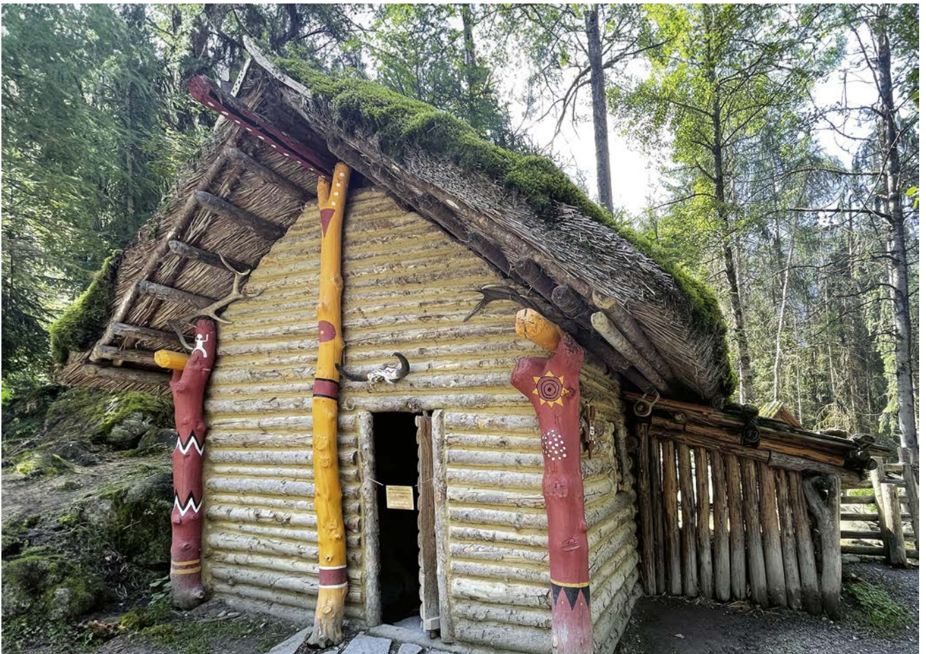
Tirol/Österreich — Nachbau eines Steinzeitblockbaus im Ötztal. Zwischen den schlüssig gesetzten Hölzern wurde mit Moos, Pflanzenfasern und Lehm abgedichtet.
