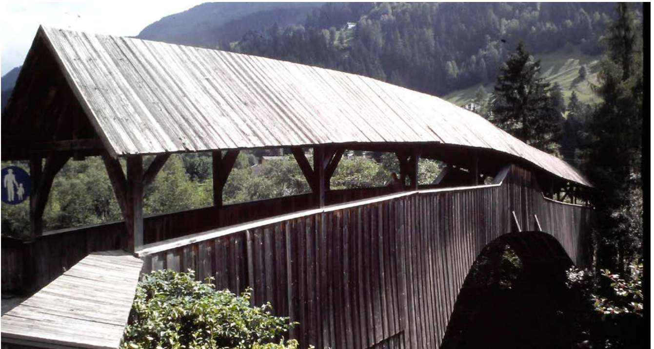
Holzbrücke mit Brettdach. Da die Bretter über die gesamte Dachlänge reichen, ist das Dach nicht hundertprozentig dicht, was aber bei einem offenen Bauwerk kein großes Problem ist.
