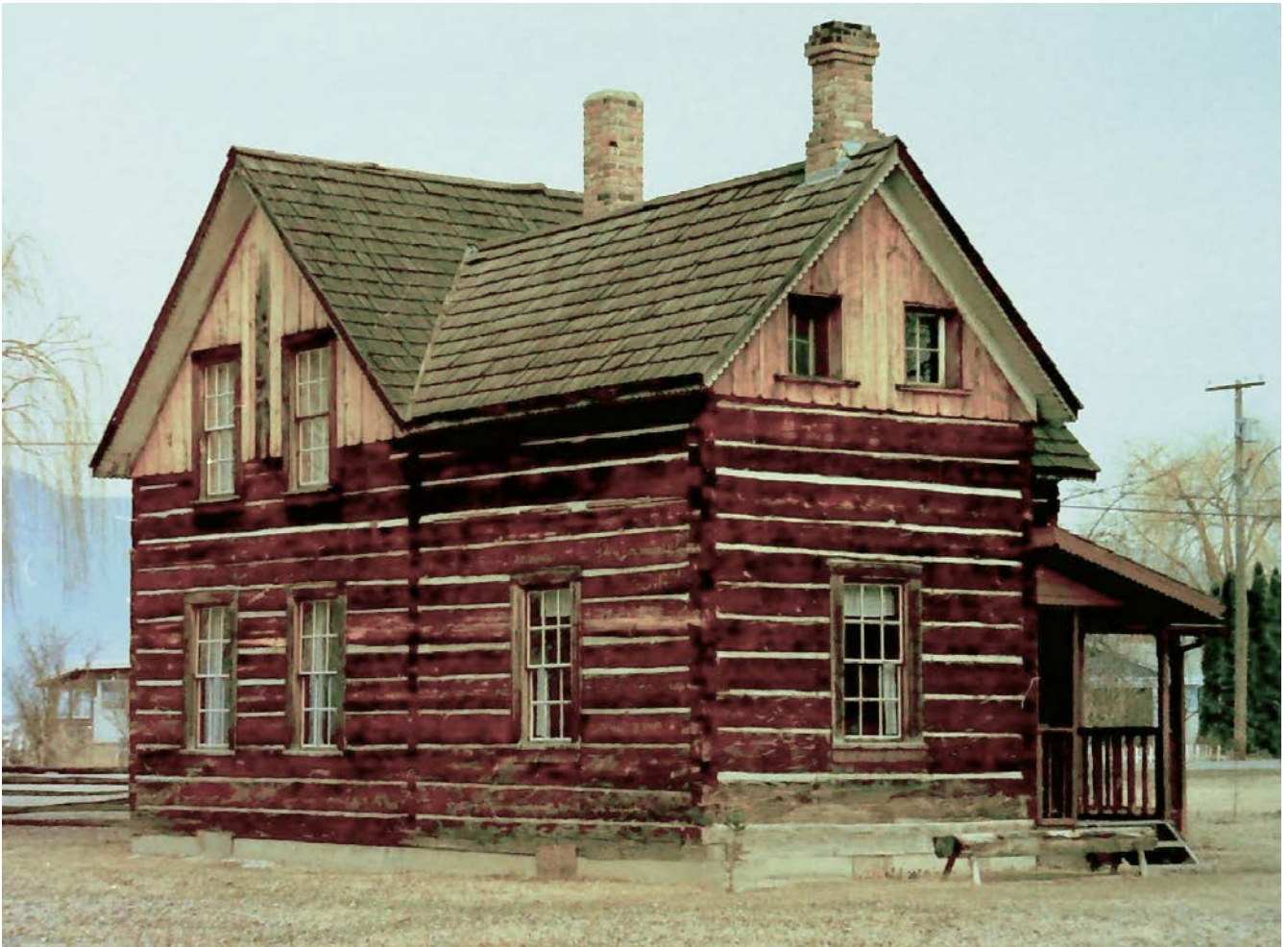
USA & Kanada — Traditionelle Blockbauweise
