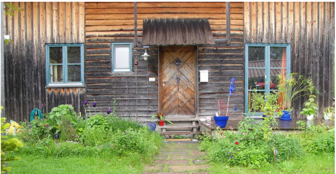
Detail am selben Haus - das abgehängte Brettdach über dem Eingang.
