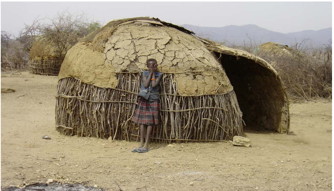
Afrika/Kenia — Traditionelle Manyatta vom Volk der Turkana, die als Halbnomaden im Norden Kenias leben. Die in den Boden gerammten Stöcke werden mit Rinderdung „ausgemauert“. Nach ihren Aussagen ist er besser als Lehm, weil er natürliche Faserstoffe beinhaltet, sich bei Regen nicht so schnell auflöst und vor allem die Fliegen aus der Manyatta fernhält.
