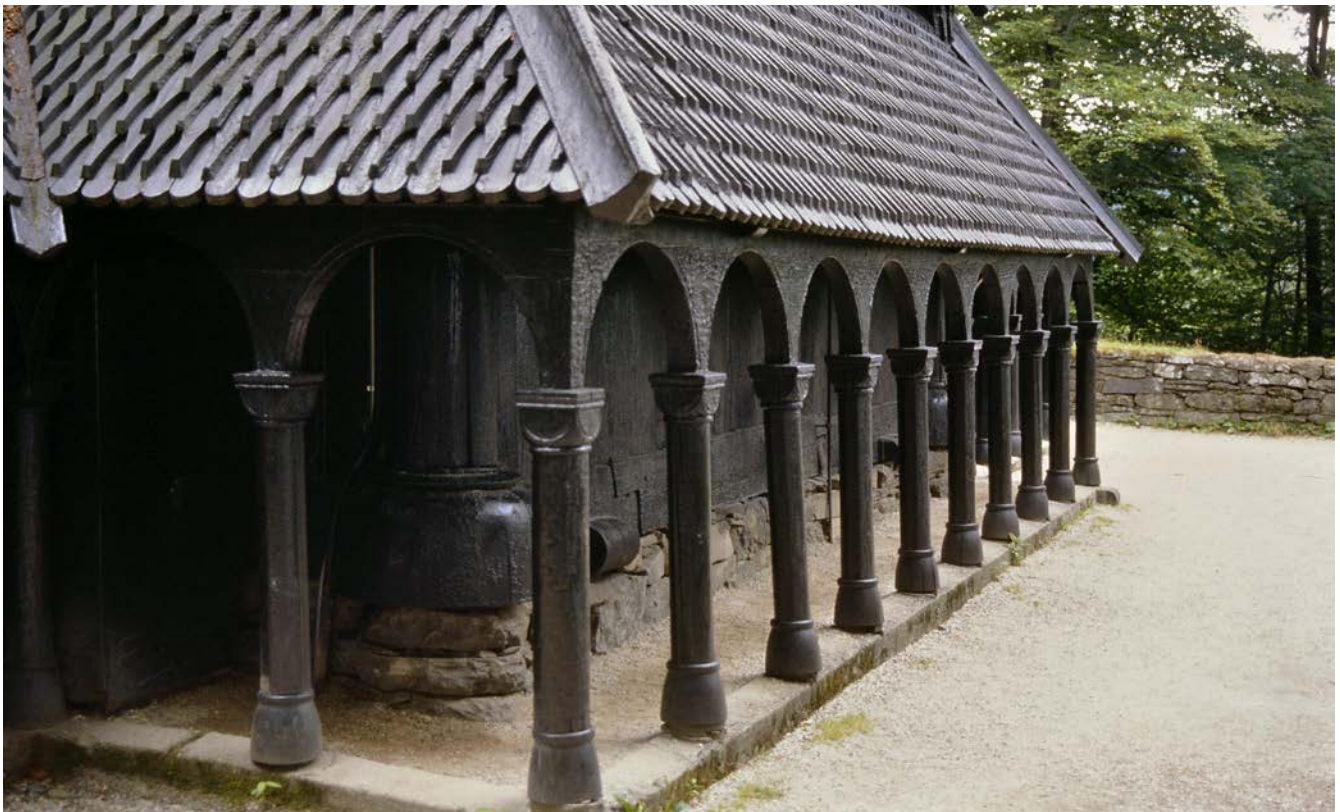
Norwegen/Bergen – Die Holzsäulen des Kreuzgangs sind ebenso wie die Holzschindeln geteert
