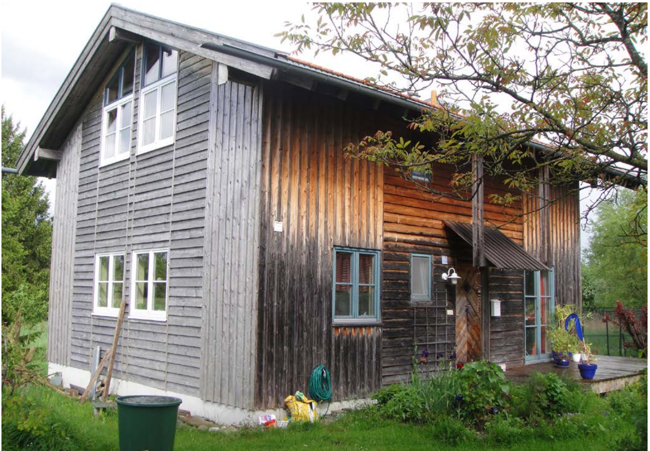
Richtungswechsel der Verschalung bringt optische Spannung in die Fassade. Zu beachten ist auch das Vordach und, je nach Vordach und Himmelsrichtung, die unterschiedliche Verfärbung.
