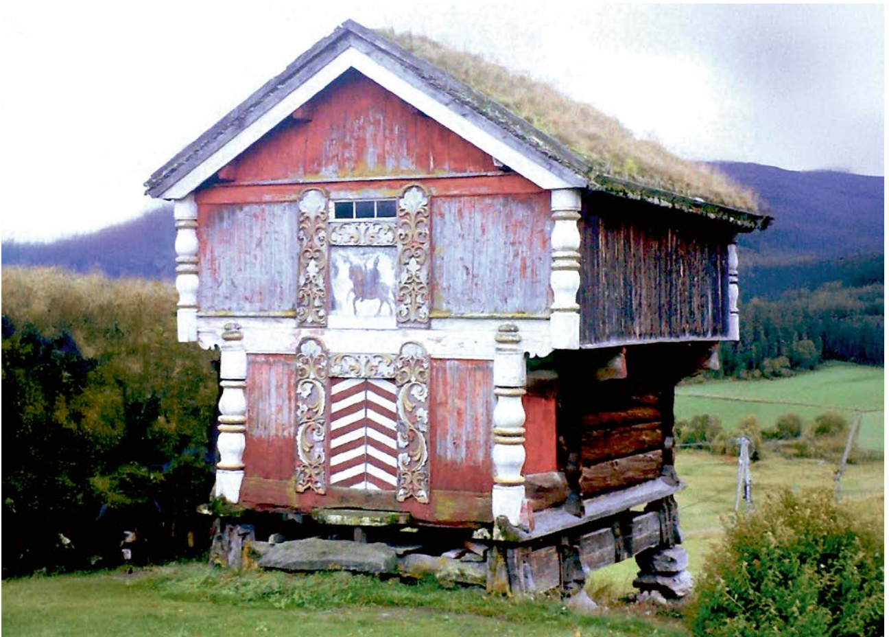
Norwegen – Getreidespeicher mit Grasdach mit Unterdach auf Birkenrinde zur Abdichtung
