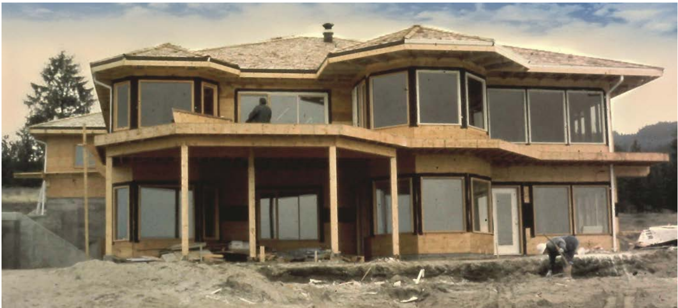
Rohbau eines Holzrahmenhauses in Kanada
