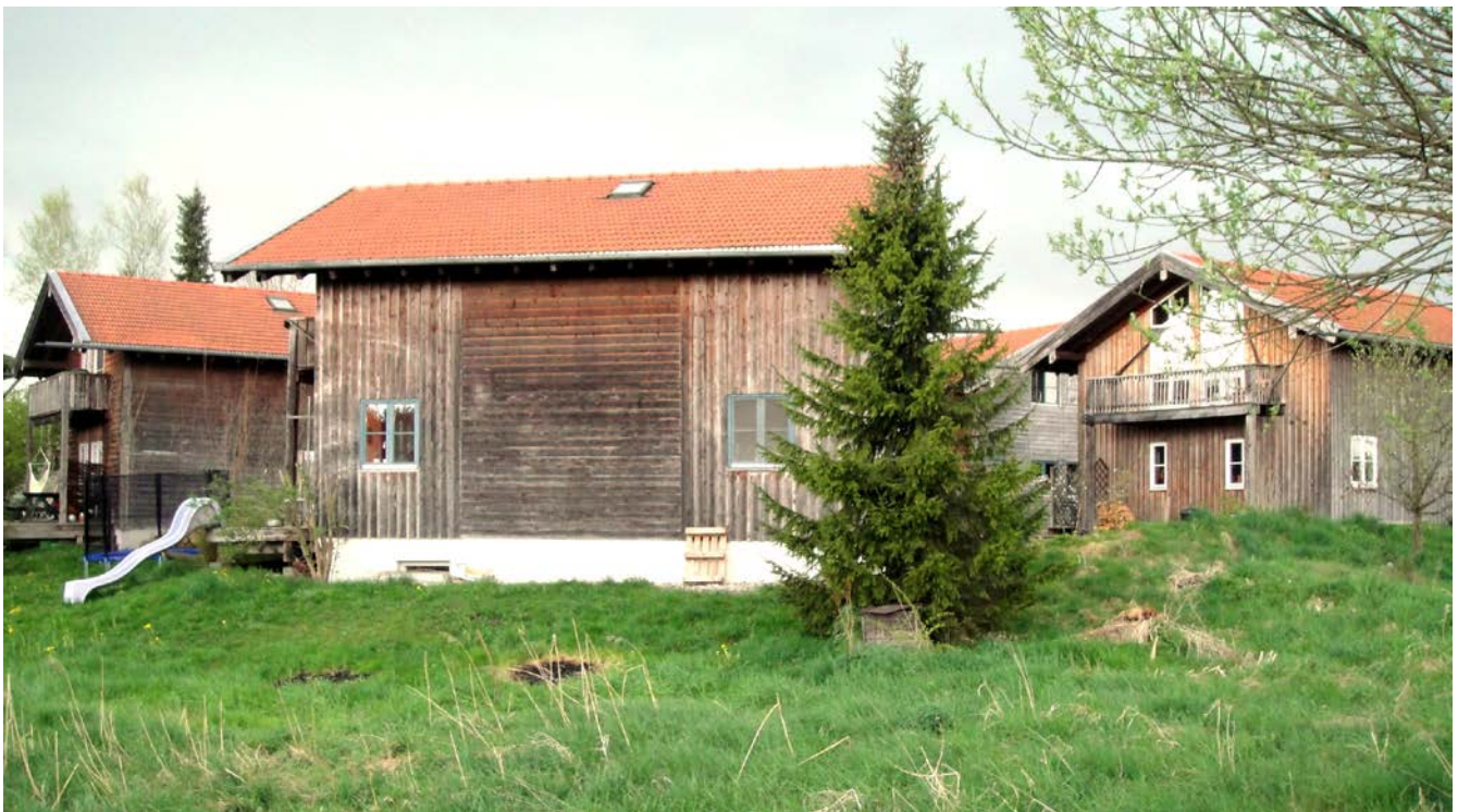
Oberbayern – Nordostseite von 20 Jahre altem Haus mit naturbelassener Fassade. Die wenig beregnete Ostseite beim rechten Haus blieb heller.
