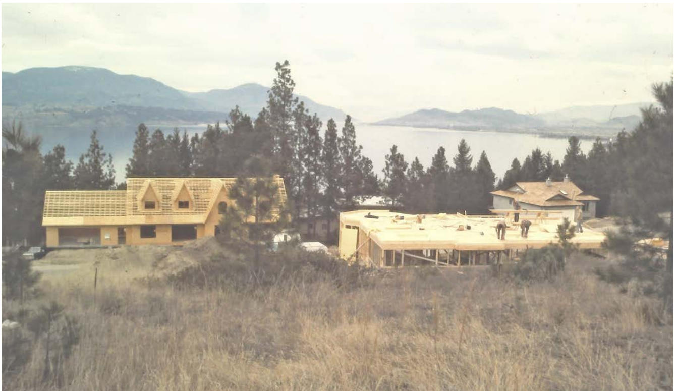
Kanada – Baustelle an der Westküste
