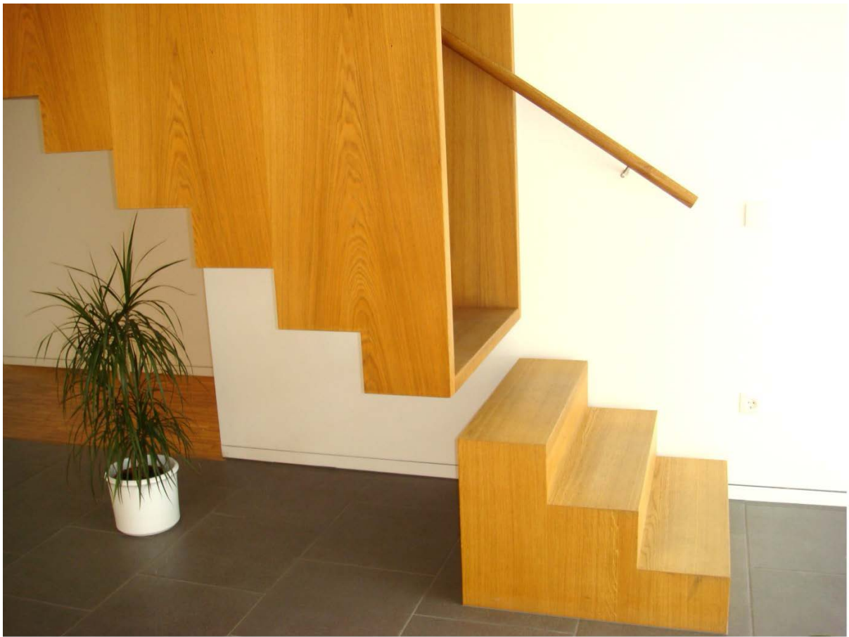
Deutschland – Abgehängter Treppenkasten und drei freistehende Antrittsstufen
