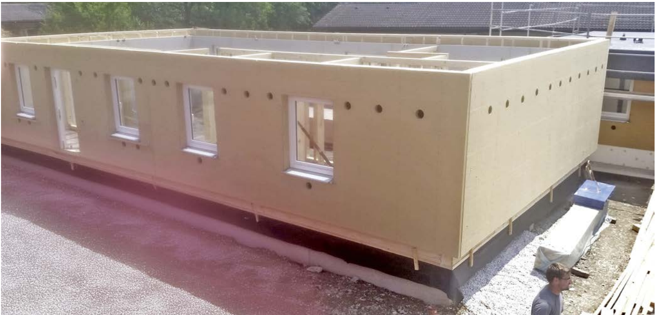
Bayern – Holztafelbau ; Die Fenster wurden schon in der Abbundhalle der Zimmerei eingesetzt
