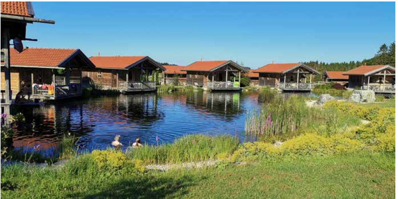
Ferienwohnanlage in Truchtlaching am Chiemsee
