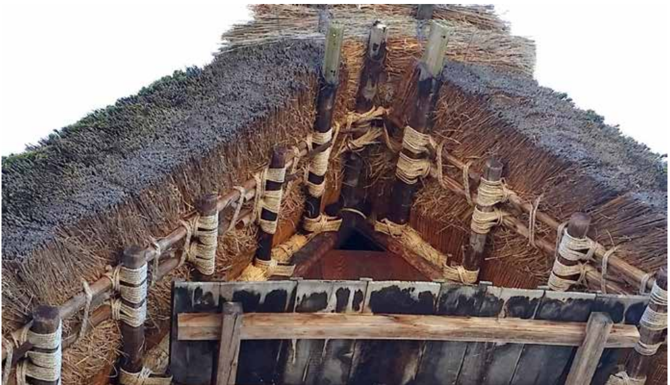
Alte Verbindungstechnik mit Schnüren - bei Erdbeben elastischer
