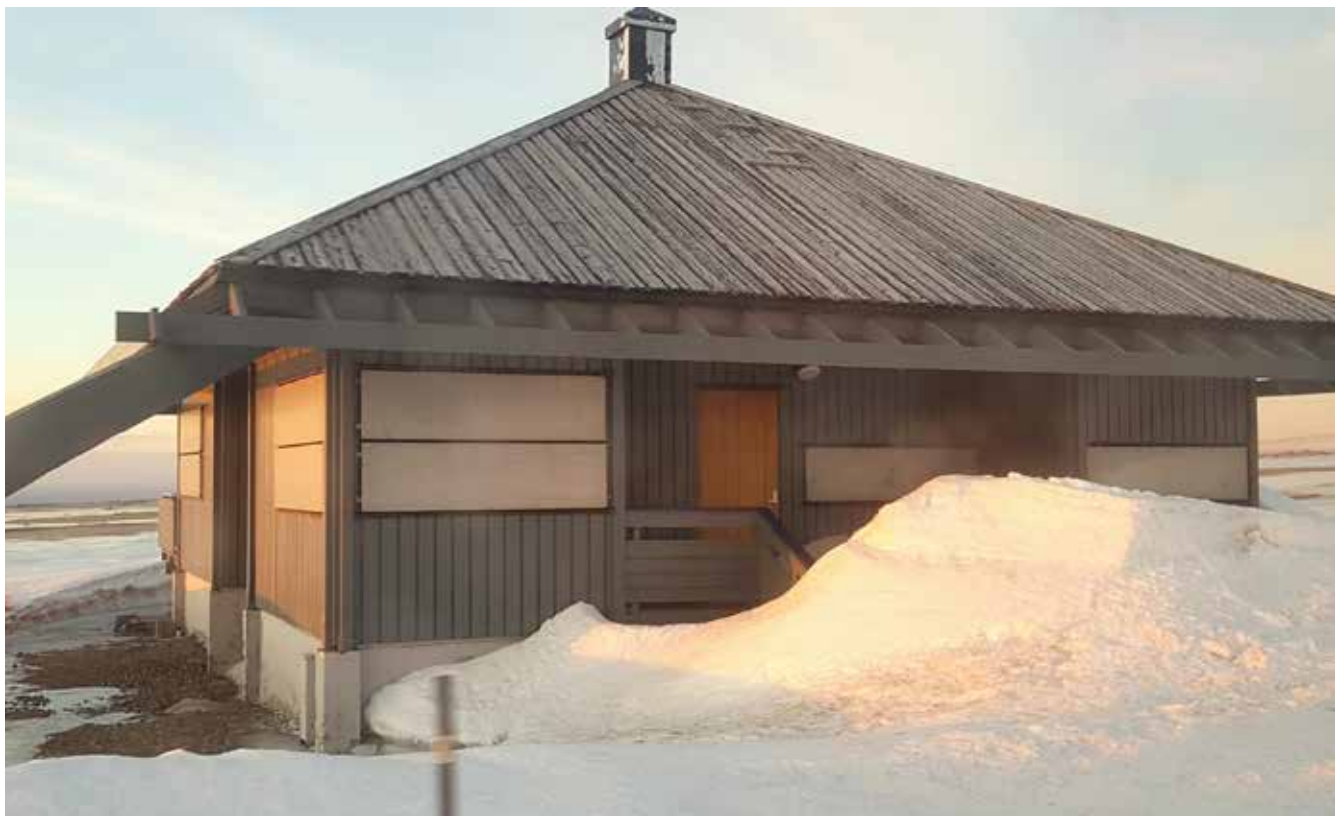
Nördlichstes Haus Europas am Nordkap - als Dacheindeckung ein Brettdach
