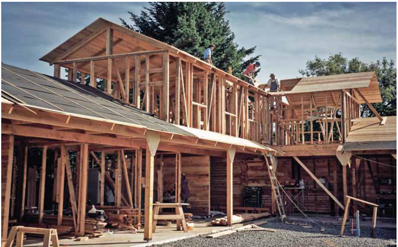
Rohbau in Villarrica
